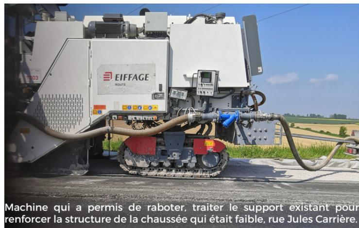
Machine qui a permis de raboter, traiter le support existant pour renforcer la structure de la chaussée qui était faible, rue Jules Carrière.
